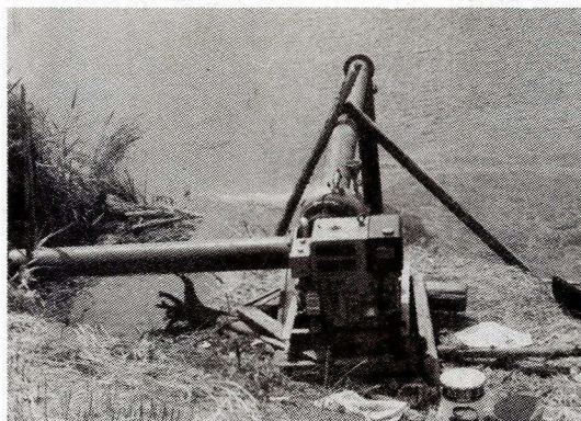
大活躍した揚水ポンプ
