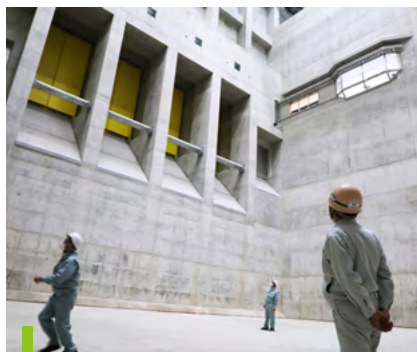
空のごみピット内。ごみが搬入される前の貴重な光景で、黄色の扉からピット内にごみが入られる
