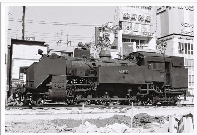
新橋駅西口広場に設置中の C11 形蒸気機関車（昭和 47 年）
