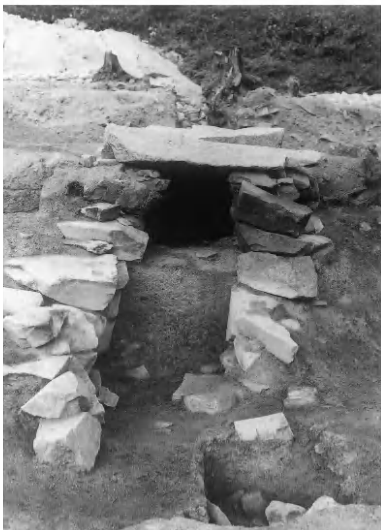
4 3号墳石室開口部（南西から）
