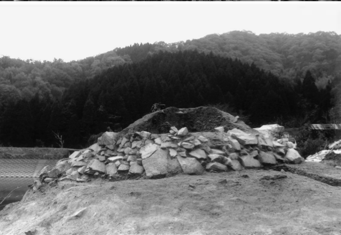
3 1号墳盛土内石積（東から）
