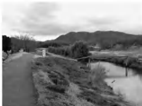
写真6 本村～下土田に架かる橋（南から）
