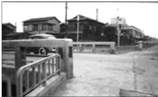
昭和35年 麻耶寺橋(荏原7丁目)
