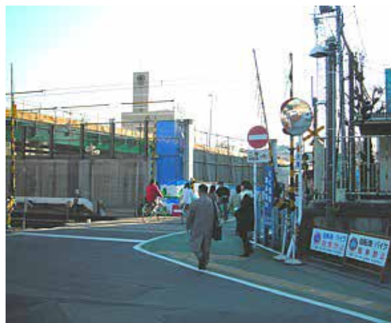
建設中の椎名橋と近接する踏切と駅
