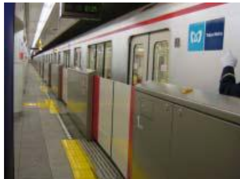
地下鉄のホームドア (2007年 バリアフリー整備ガイドラインより)
