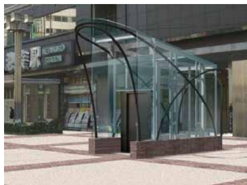
池袋駅西口のバリアフリー対応エレベーター
