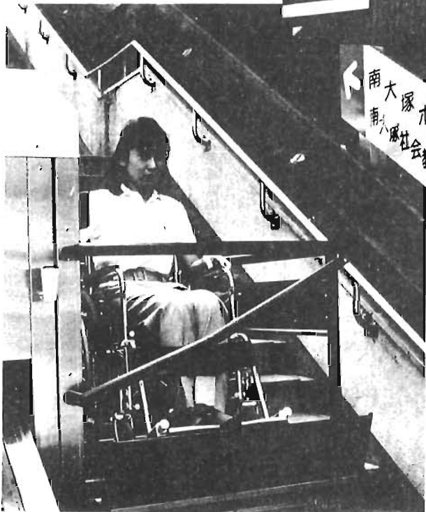
南大塚社会教育会館の階段に車いす用昇降機を設置しました。会館に併設している南大塚ホールへ行く通路にも垂直型の昇降機を設置し、ホールには、車いす用客席、車いす用トイレを整備してあります。
