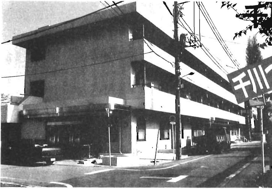
完成した千川二丁目施設
