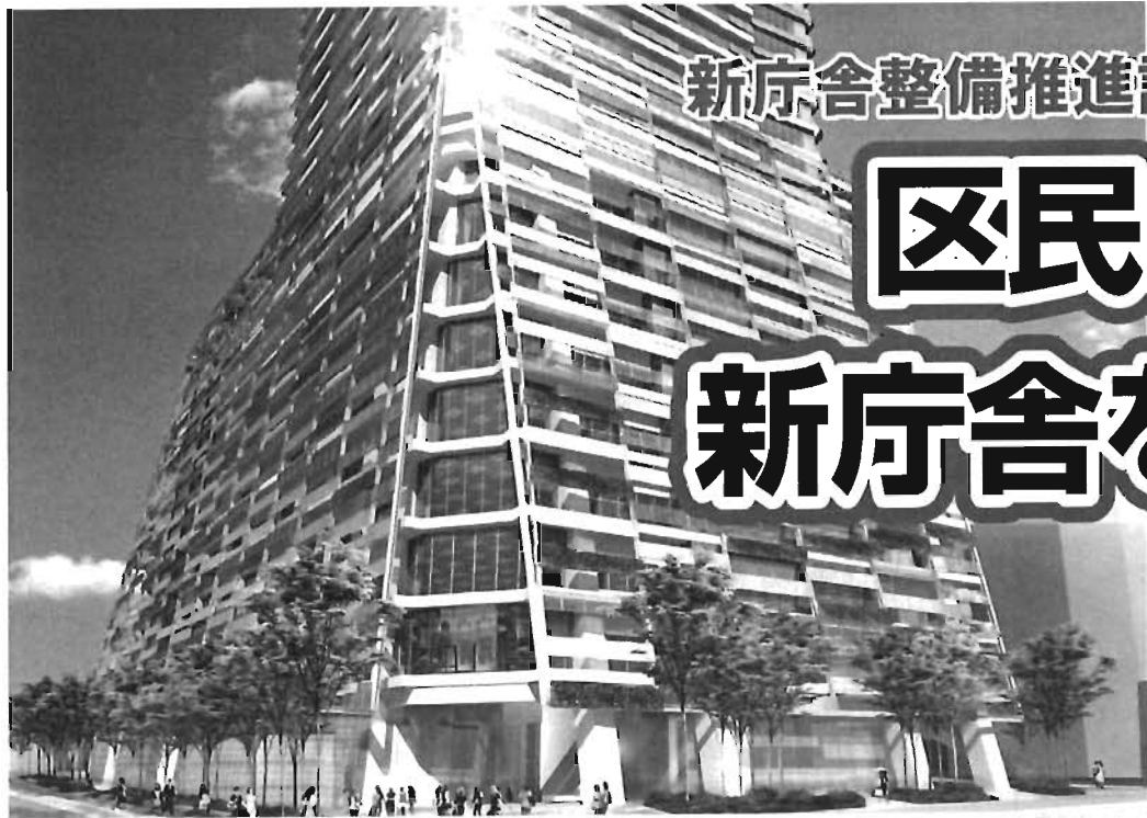
北東面からみた庁舎部分の外観
