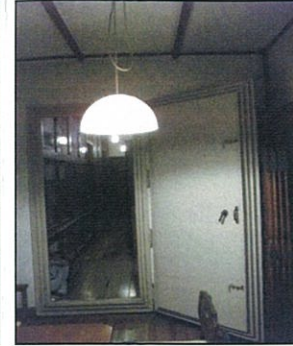
⑦【防火扉(書斎入口)】
